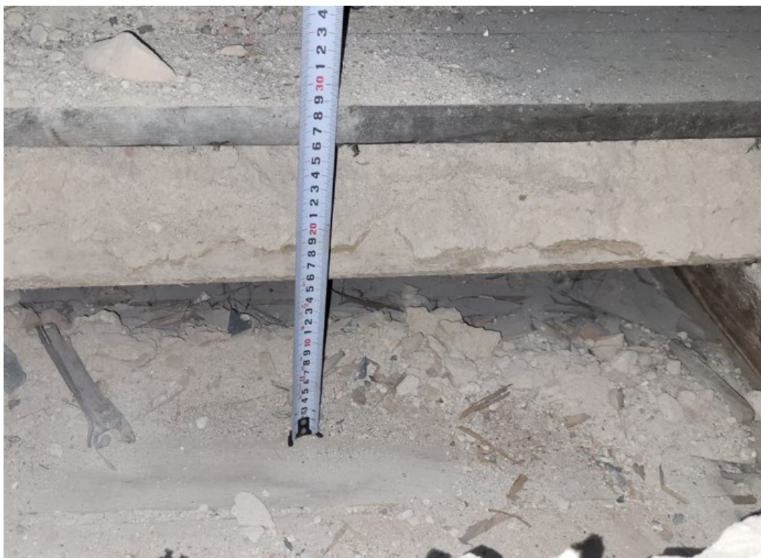
Zdjęcie nr 4-Odkrywa stropu nad I piętrzem
