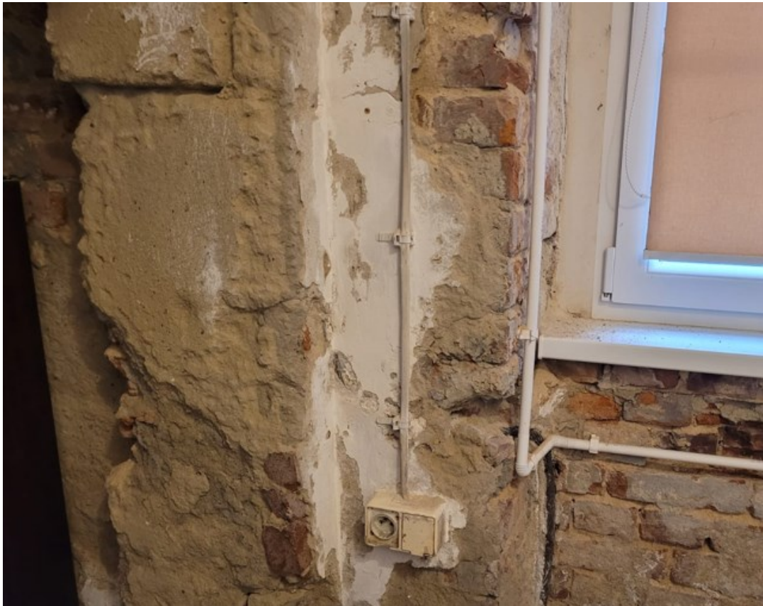
Zdjęcie nr 2-Zawilgocone i odpadające tynki w piwnicy
